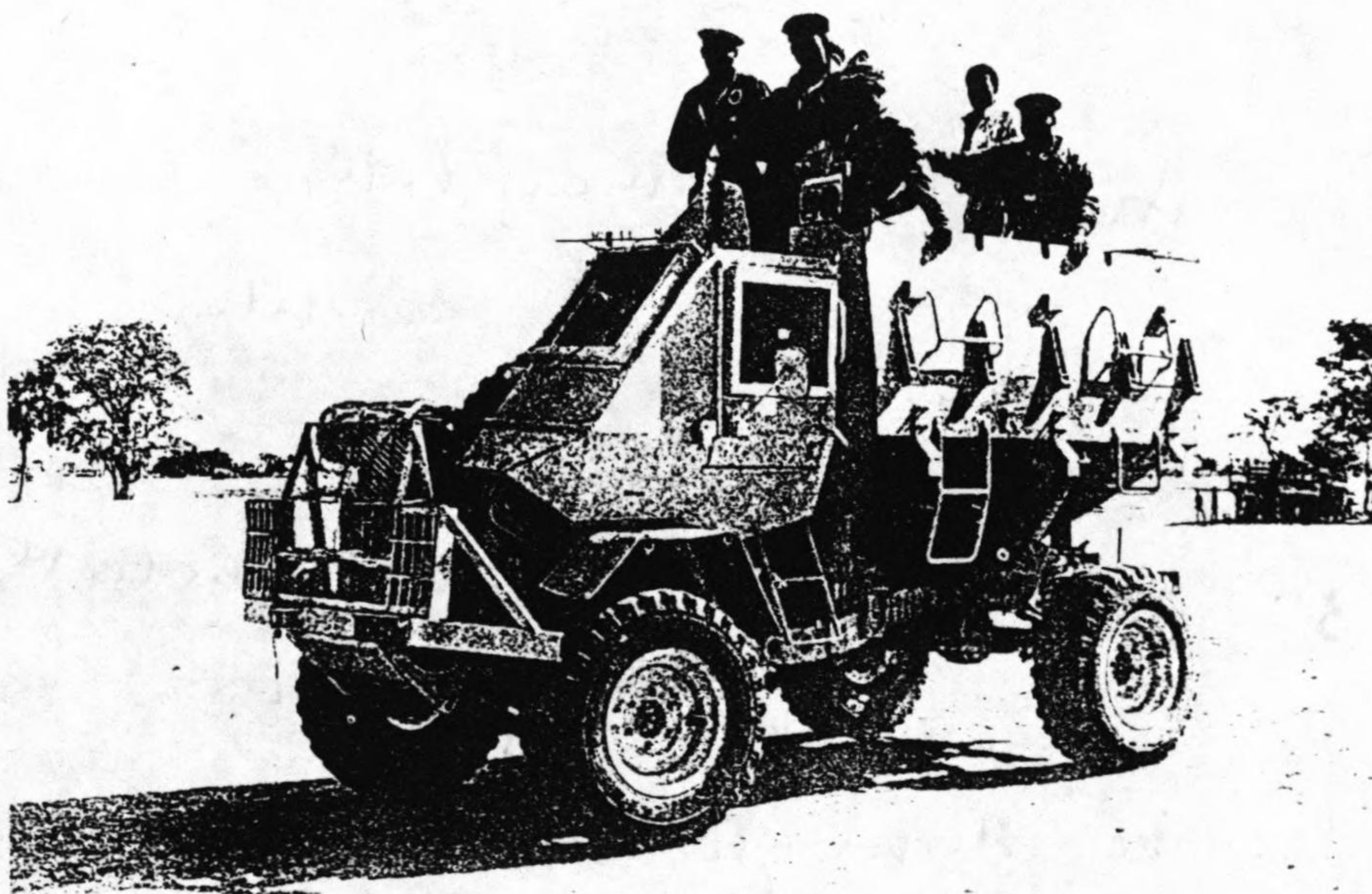
Rüstungsgut oder nicht? Minensicheres Fahrzeug der südafrikanischen Armee auf dem Fahrgestell des Unimog U 416.
