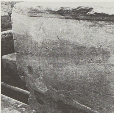
As gevolg van swak herstelwerk kan ou barste weer ooptrek
