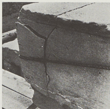
As gevolg van swak herstelwerk kan ou barste weer ooptrek
